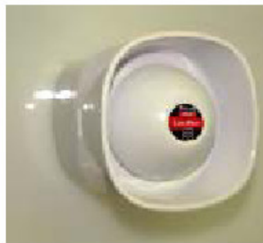
Abbildung 4: Fluchtwegschild und Lautsprecher für „directional sound“.
